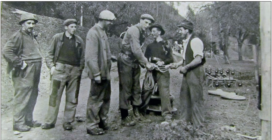
V.l.: Fritz Mosimann, sen., Küferhüsli, Rohrmatt; Paul Hügli, Unter-Saalen; Toni Duss, Menzau; Hans Schwegler, jun., Oberheim; Hans Schumacher, Wassermatt, und Kaspar Dubach, Ober-Fluh, erstellen 1964 die Transformatoren-Station Kanzelsagen.
