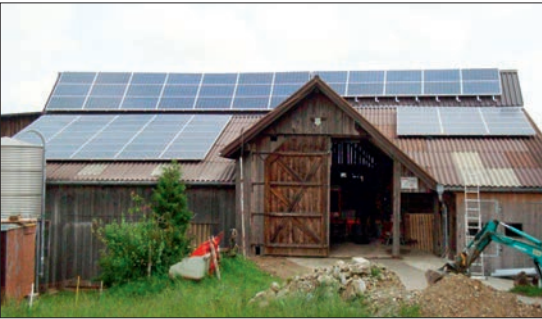
Photovoltaikanlage auf dem Scheunendach Unter-Saalen.
