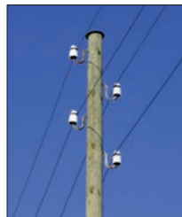
Seit ungefähr 1970 sind nur noch braune Isolatoren im Handel. Angeblich sollen diese weniger auffallen als die weissen.
