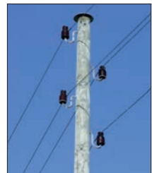
Seit ungefähr 1970 sind nur noch braune Isolatoren im Handel. Angeblich sollen diese weniger auffallen als die weissen.
