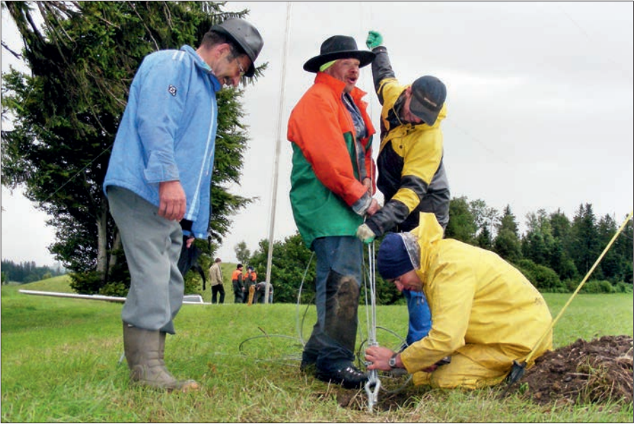
Aufbau der Windmessenanlage auf der Kurzhubelegg.
